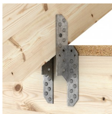
Fijación de pie de cabrio con forjado
