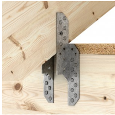
Fijación de pie de cabrio con forjado
