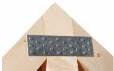
Unión de 3 elementos por placas perforadas NP
